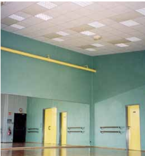
Die Thermocassette erzeugt eine angenehme Wärme im Fußbodenbereich in Räumen, in denen häufig barfuß gelaufen wird.
