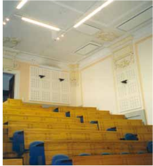
Die Deckenmontage schützt die Thermocassette gegen Beschädigungen.
