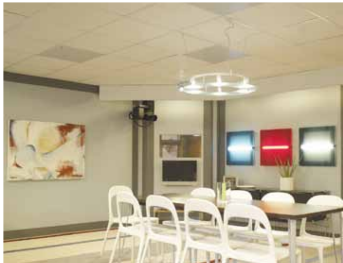
Eine Thermocassetten-Heizung in einer Zwischendecke ist eine attraktive und fast unsichtbare Heizmöglichkeit. Die Lage der Heizkassetten kann bei einer veränderten Raumnutzung sehr einfach geändert werden.
