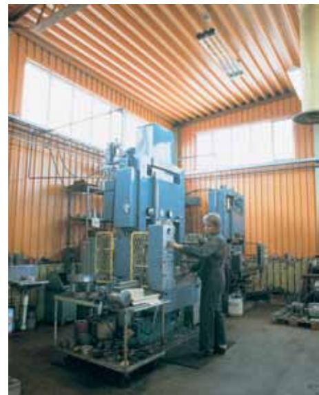
Mit IR-Wärmestrahlern kann die Temperatur in unterschiedlichen Raumbereichen perfekt angepasst werden. Punktuell Heizen erhöht den Komfort und verringert die Heizkosten.
