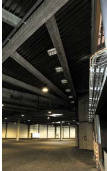
IRCF können an der Wand oder an der Decke montiert werden und eignen sich besonders gut für Gebäude, die sporadisch genutzt werden, wie diesen Startbereich einer Gokart-Bahn
